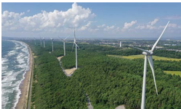
A-WIND ENERGYの風力発電所 提供：株式会社A-WIND ENERGY
